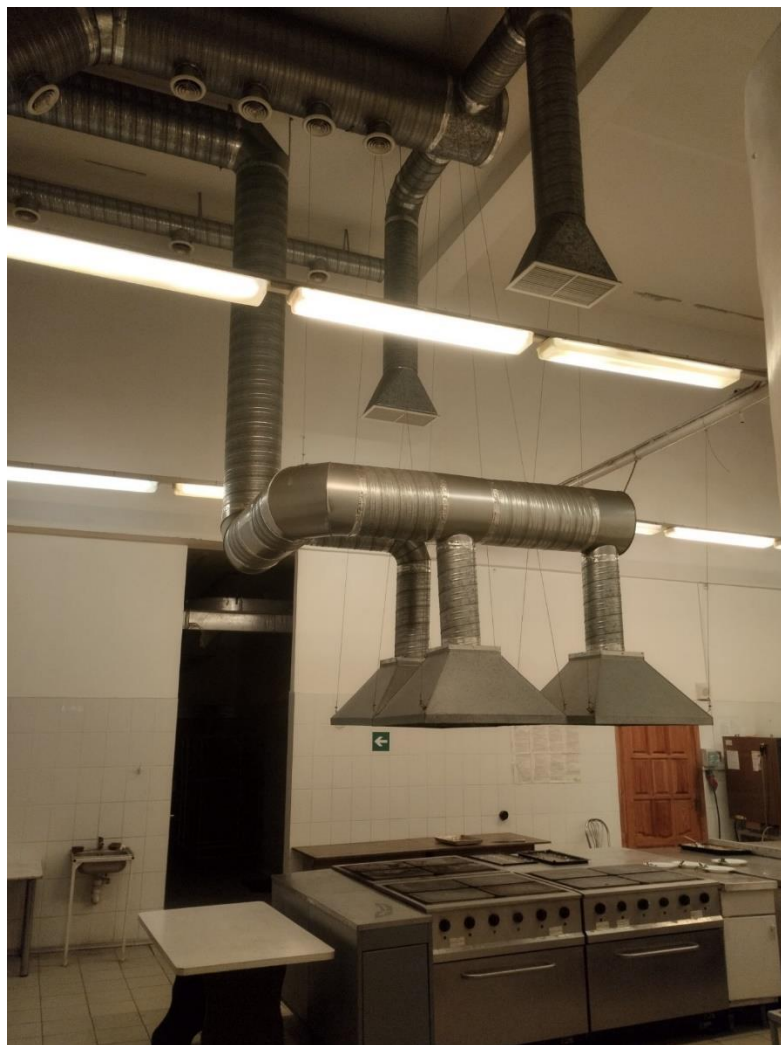
Рисунок 1.7 – Местный отсос-раструб с выступом
