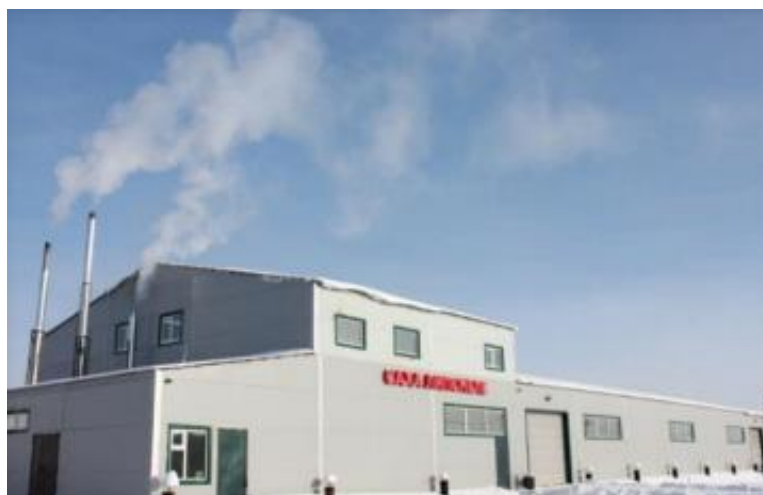
Рисунок 5.1 - Фото общего вида здания
